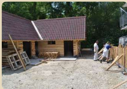
Výstavba Sedliackeho dvora Construction of Farmer's House
