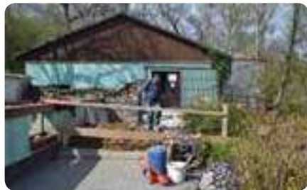
Oprava kanalizácie Sewer Repairing
