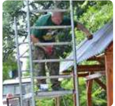
Budovanie prístrešku Production of the shelter
